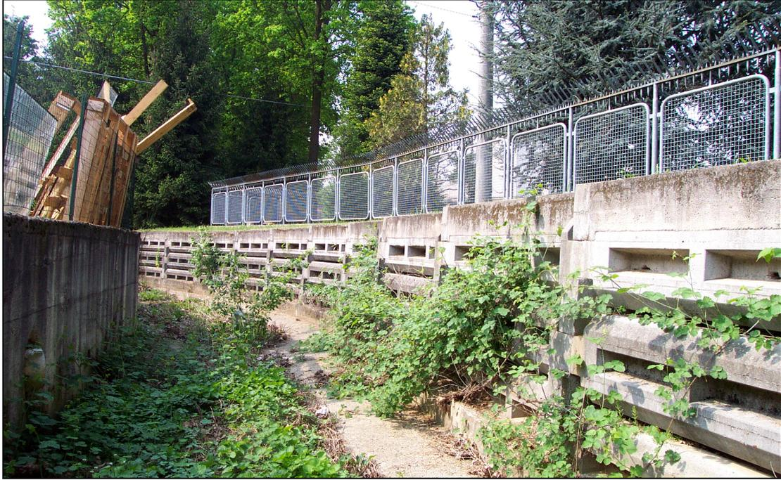
*Foto n. 8 – opere di sistemazione spondali con elementi prefabbricati - Torrente dei Ronchi*
