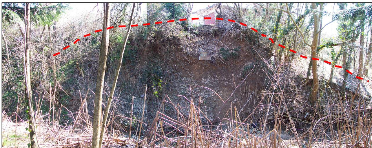
*Foto n. 4 e 5 – Torrente S. Michele/S. Giorgio; sponda idrografica sinistra in erosione a valle del ponte di Via Repubblica (sopra); sponda destra (sotto)*
